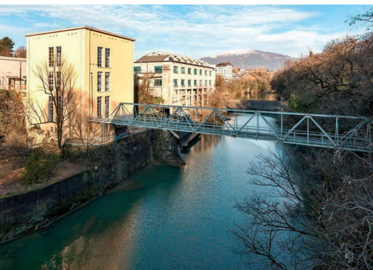
La centrale idroelettrica di proprietà sul fiume Brembo
